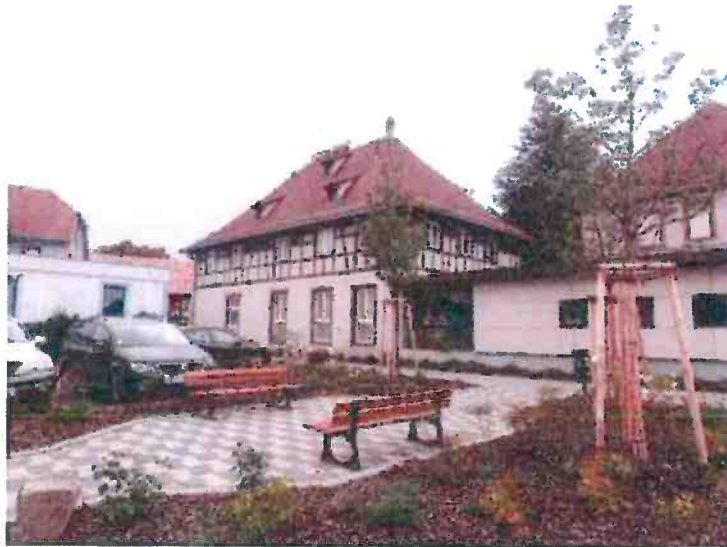
Ancien hôtel du maître de poste, 46 route Lyon
